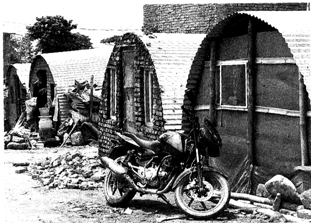
トタンぶきの簡易な仮設住宅が並ぶ
